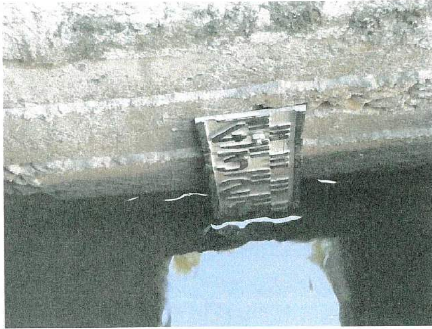
Figura 3: Scala graduata posizionata all'interno del pozzetto per la rilevazione del livello idrometrico sopra la soglia dello stramazzo.
